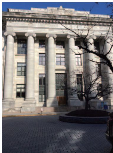
ゴードンホール。ハーバード・メディカル象徴的建造物。現在は修理中。
